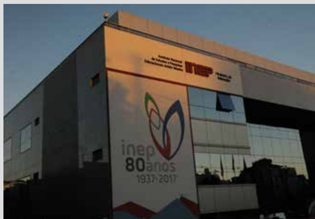
11. Edifício Villa-Lobos- DF
