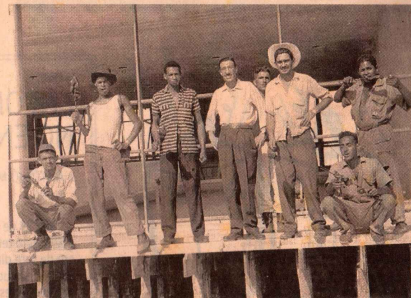
Rosendo (C) e operários durante churrasco em um intervalo das obras
