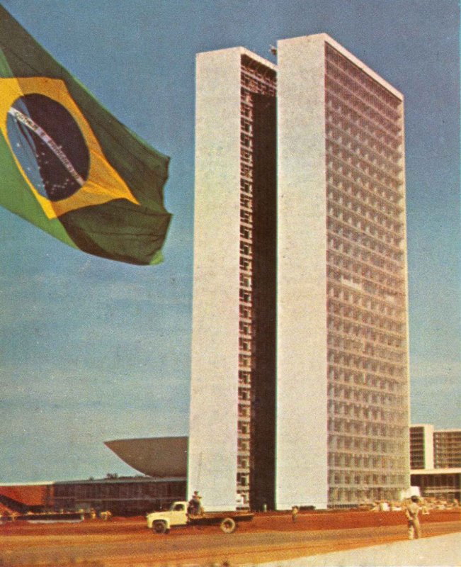
Os edifícios dos anexos onde se localizam os escritórios dos Deputados, Senadores e ainda a administração geral do Senado e Câmara. A "ECEL" cooperou ativamente na construção destes magníficos e imponentes prédios, localizados na praça dos Três Poderes.
