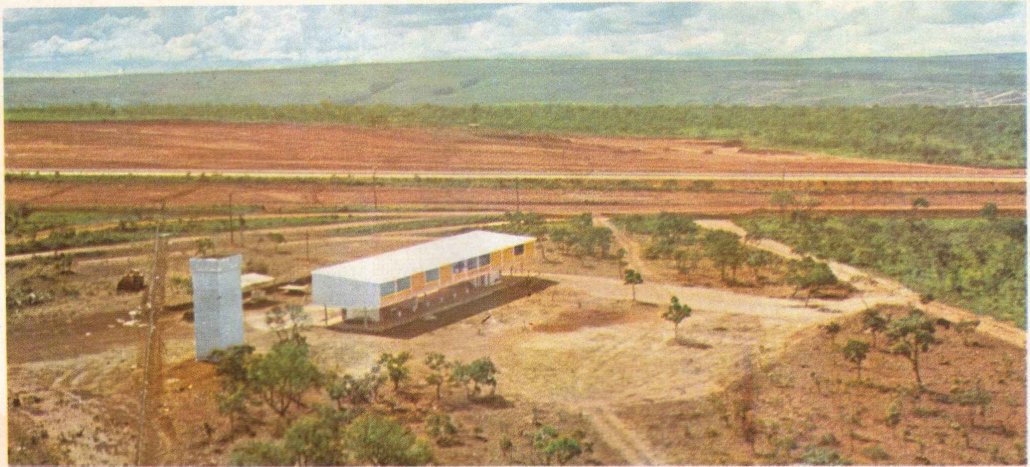
A primeira construção presidencial foi substituída pelo novo Catetinho, ou seja a RP-2. Nesta nova e segunda residência, ainda não definitiva, o Presidente pôde despachar e instalar-se com mais conforto.
