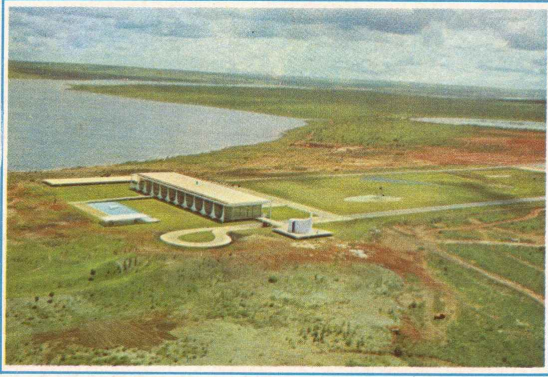
Outra foto aérea do Palácio da Alvorada, podendo-se notar a piscina localizada na parte detrás do Palácio. Ao longe, o famoso lago Paranoá.
