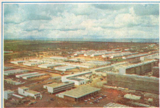
Detalhe aéreo, vendo-se as construções geminadas da fundação da casa popular, Caixa Econômica, Super-Mercado, Posto de Saúde, avenida W-3, etc.
