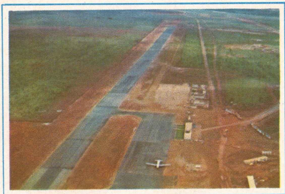
A primeira construção definitiva foi a pista pavimentada do aeroporto. Construída em tempo "record", com 3.300 metros de comprimento e 45 de largura, propiciou ela o recebimento dos primeiros suprimentos necessários ao início das construções.
