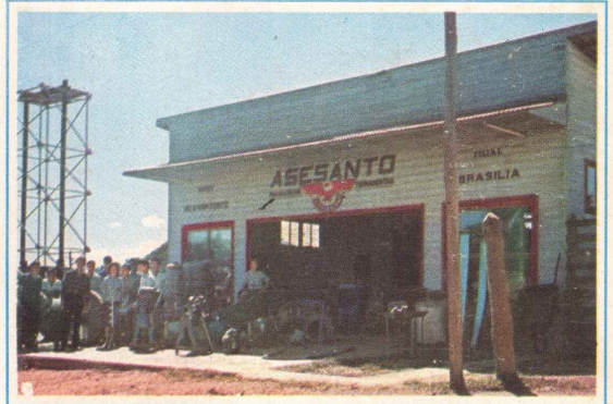
Vista da fachada da "Asesanto", na Av. Central, 45. Sua sede é em Belo Horizonte e vende Grupos Diesel, Betoneiras, Guinchos, Vibradores, Máquinas Operatrizes, Moto-Bombas, Correias para Transmissão, Motores em geral, etc.
