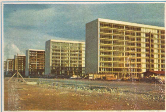
Outro aspecto do conjunto dos Ministérios, idealizado, em momento de grande inspiração, pelo arquiteto Oscar Niemeyer. A Construtora Ribeiro, em tempo hábil, deu forma ao projeto do edifício, que se vê em primeiro plano, empregando materiais de primeira classe.
